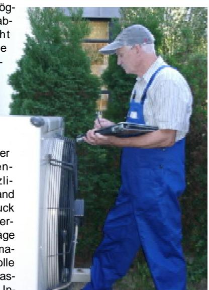
Der mobile Einsatz von TGM führt zu einer lückenlosen Anlagenhistorie ohne zusätzlichen Erfassungsaufwand im Büro. Auf Knopfdruck kann nachgesehen werden, wie sich die Anlage entwickelt hat. Automatisch erstellte Protokolle der „nicht okay“-Teile lassen sich zur weiteren Instandsetzung nutzen
